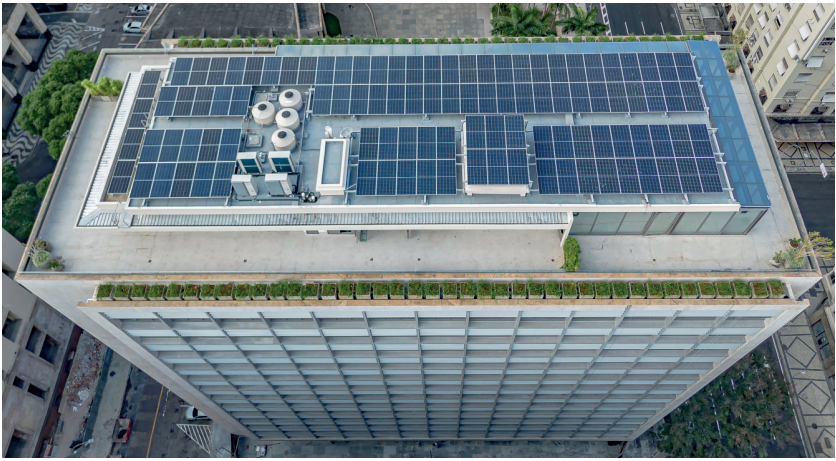
FOTO C - Telhado PHOTO C - Rooftop
