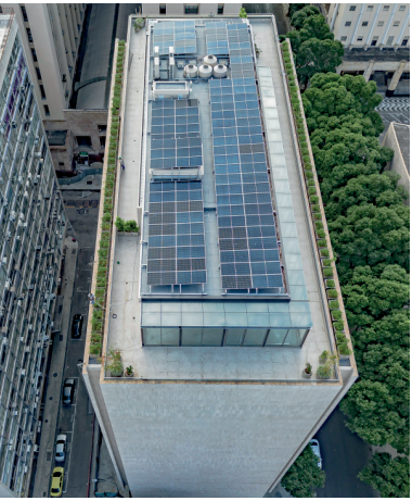
FOTO D - Telhado PHOTO D - Rooftop
