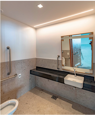
FOTO B - Sanitário PHOTO B - Toilet
