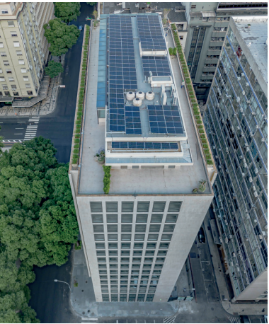
FOTO B - Telhado PHOTO B - Rooftop
