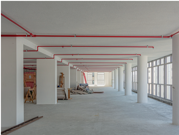
FOTO A - Sala 01 / 02 PHOTO A - Room 01 / 02
