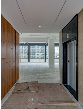
FOTO A - Hall Elevadores PHOTO A - Elevator Hall
