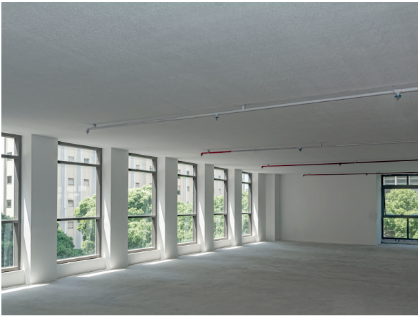
FOTO C - Sala 02 PHOTO C - Room 02
